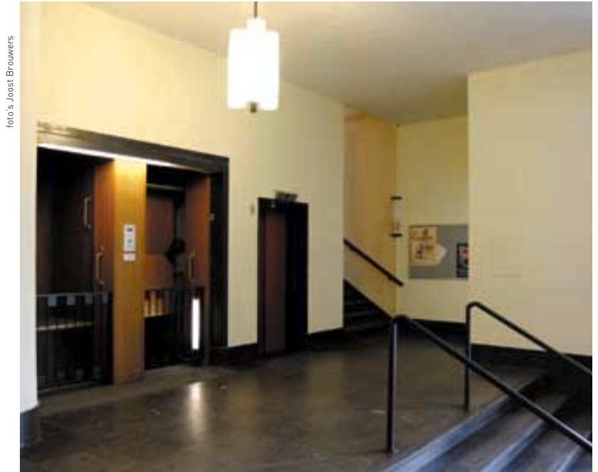
Een deel van een hal met de gehandhaafde paternosters
