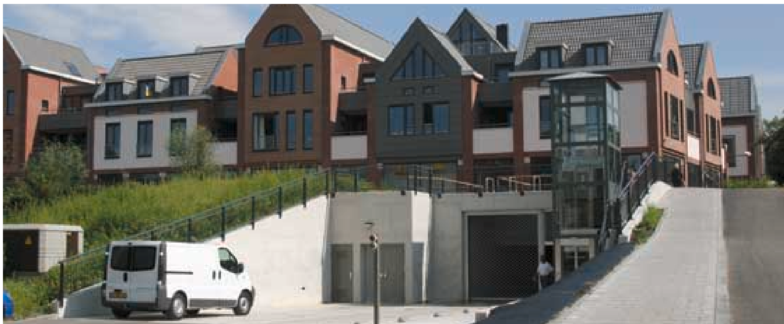
De parkeergarage met lift en het aquaduct over de ringsloot
