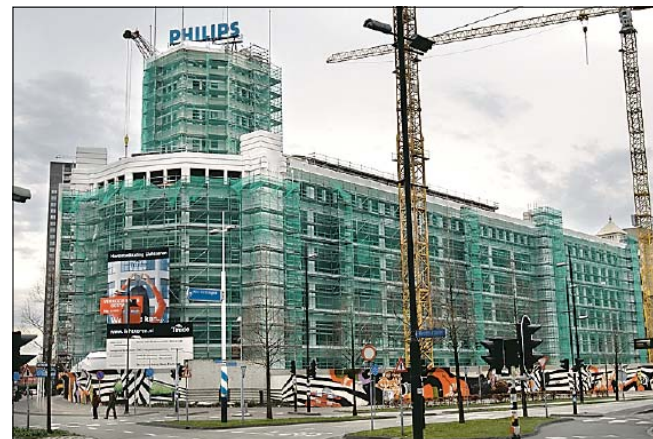
Philipsgebouw in Eindhoven. Foto's Marcel van den Bergh / de Volkskrant
